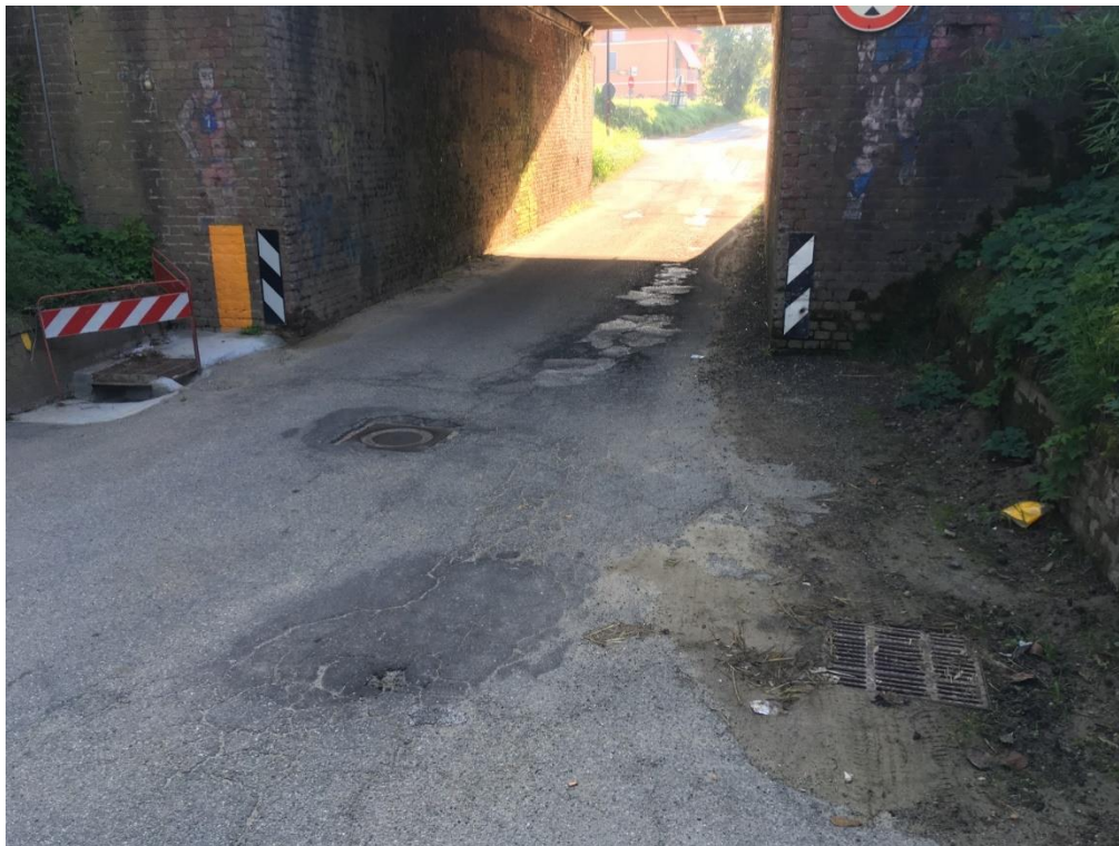
Foto 2: Via Pralormo cavalcavia ferroviario
